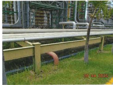
ภาพที่ 2-33 การทำคูป้องกันบริเวณแนวท่อขนส่ง Vent Gas และ Nitrogen
