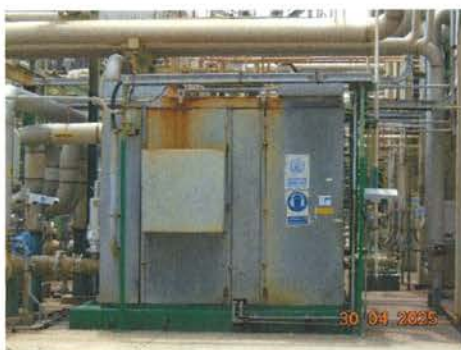
ภาพที่ 2-12 ถังกักเก็บเสียงดังจากเครื่องจักร และป้ายเตือนให้สวมใส่อุปกรณ์ป้องกันเสียงดัง
