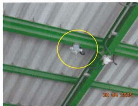
ภาพที่ 2-22 Heat Detector
