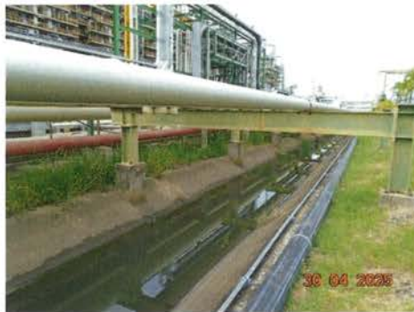
ภาพที่ 2-33 การทำคูป้องกันบริเวณแนวท่อขนส่ง Vent Gas และ Nitrogen
